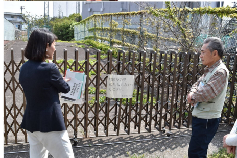
貼り紙を設置した橋の視察 (4月23日)
